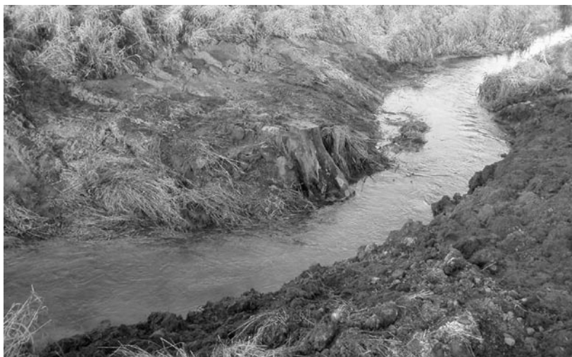
Bild 4: Störelement unmittelbar nach Bauende im Dezember 2005 (noch ohne Bepflanzung)
