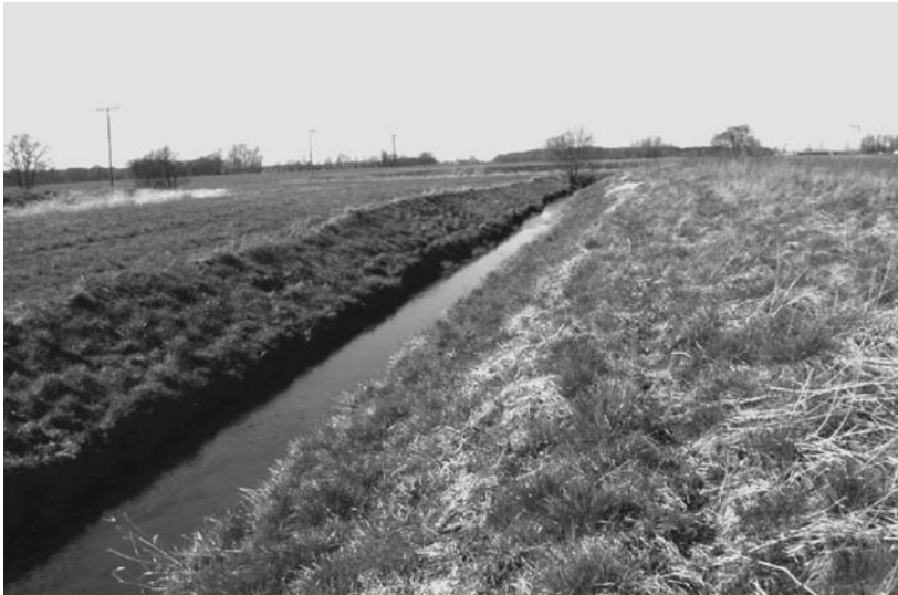
Bild 2: Ausgebauter Klosterbach innerhalb der Projektstrecke vor der Maßnahme
