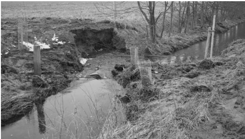
Bild 6: Böschungsabbrüche mit beginnender Hinterspülung der Baumreihe (Februar 2006)
