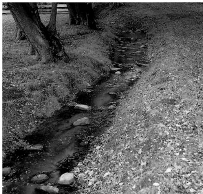
Bild 5: Renaturierte Staukaskade an der Wittbeck: aufgelöster Beckenpass
