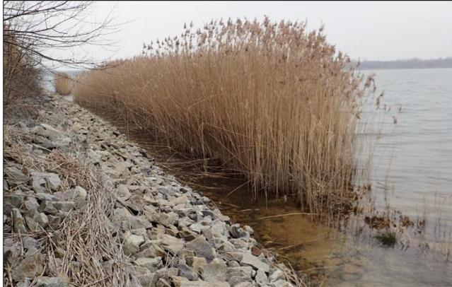
**Abbildung 62: Steinschüttung an einem Ufer mit einem relativ flachen Flachwasserbereich und Röhricht**
