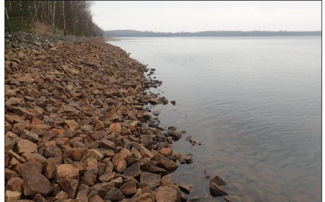
**Abbildung 63: Steinschüttung an einem Ufer mit einem steileren Flachwasserbereich ohne Röhricht**
