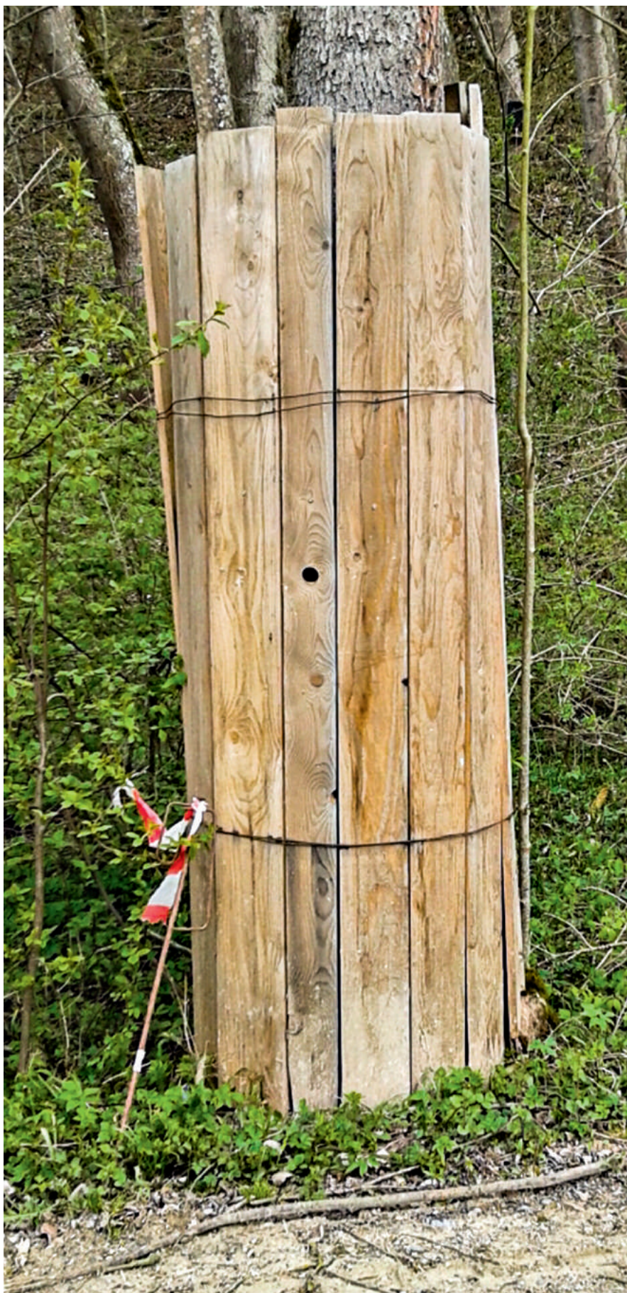
Abb. 8: Stammschutz aus Holzbrettern mit Polsterelementen zwischen Baumstamm und Brettern.
