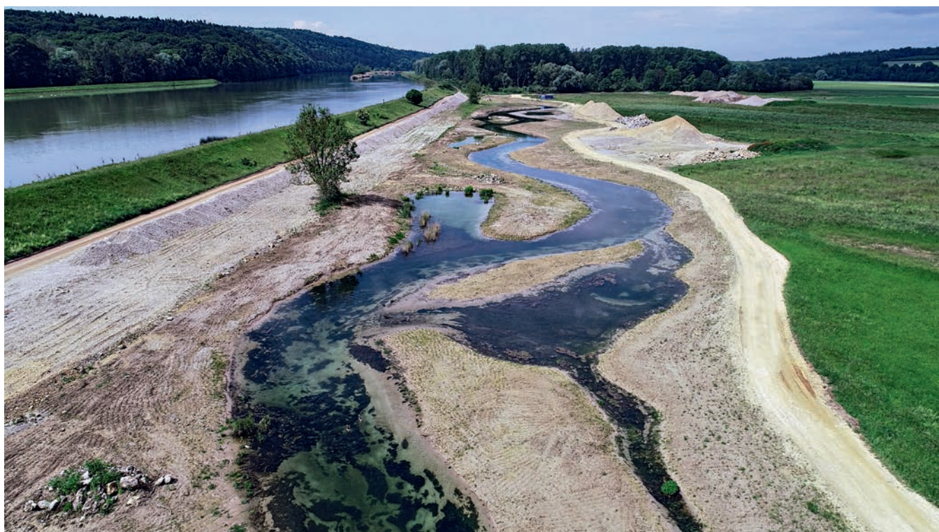
Abb. 5: Naturnahe Umgestaltung des linken Entwässerungsgrabens.
