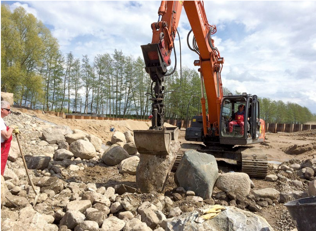
Bild 2: Durch Platzieren ausgewählter Feldsteine/Findlinge wurden die bodennahen Schlupflöcher bereits im „Rohbau“ realisiert
