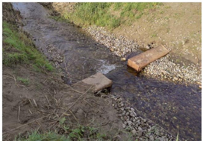
**Bild 10:** Sohlschwelle mit Wehrcharakteristik zur Sicherstellung der berechneten Wasseraufteilung bei geringen Durchflüssen
