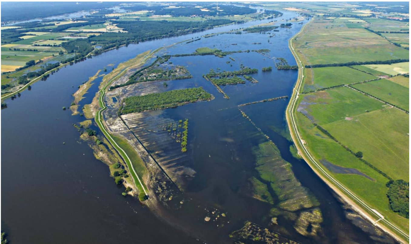
Abb. 1: Überflutete Elbaue im Gebiet der Deichrückverlegung Lenzen während des Hochwassers 2013. (Foto: Frank Meyer – RANA)
