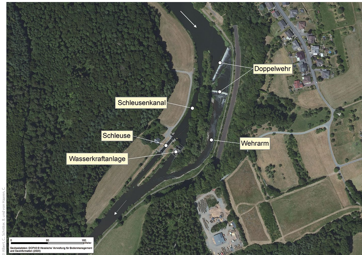
Bild 7: Staustufe Kirschhofen mit Wehr- und Schleusenanlage [6]
