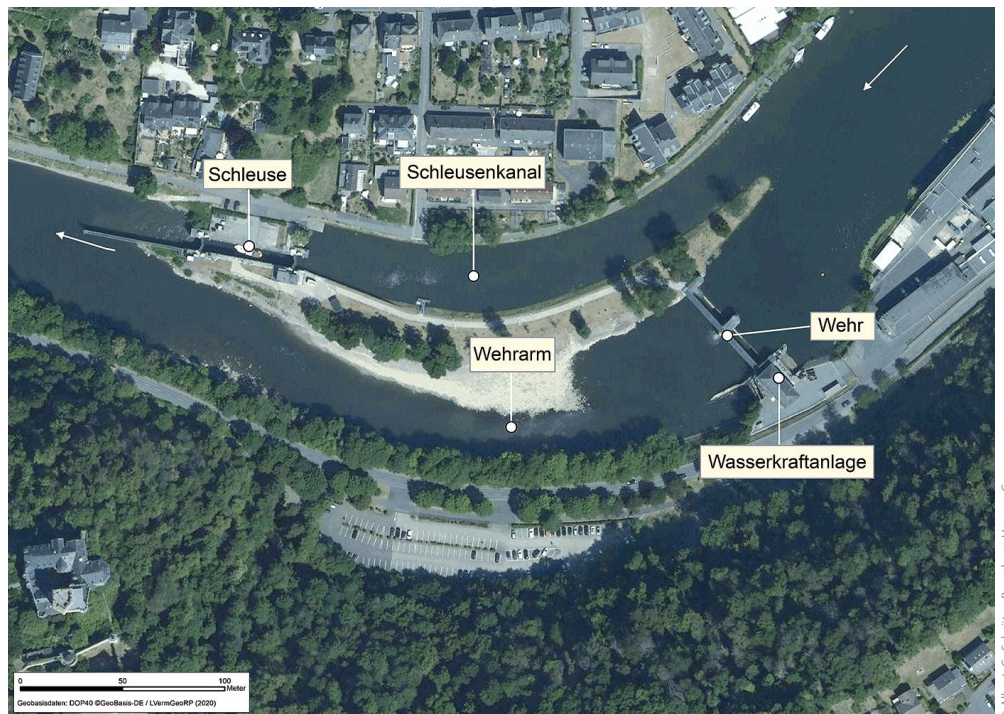
Bild 6: Staufufe Lahnstein mit Wehr- und Schleusenanlage [6]
