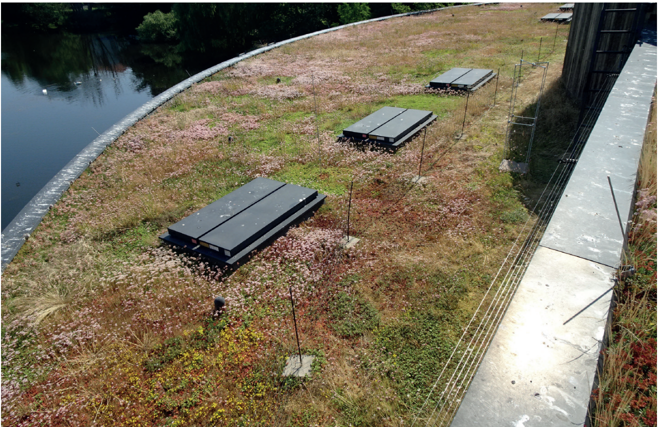
Abb. 5: Großflächiger Blühaspekt von Sedum album auf TF 1, (Blick nach Osten mit Herrensee). (Foto: A. Krumbiegel, 26.06.2023)
