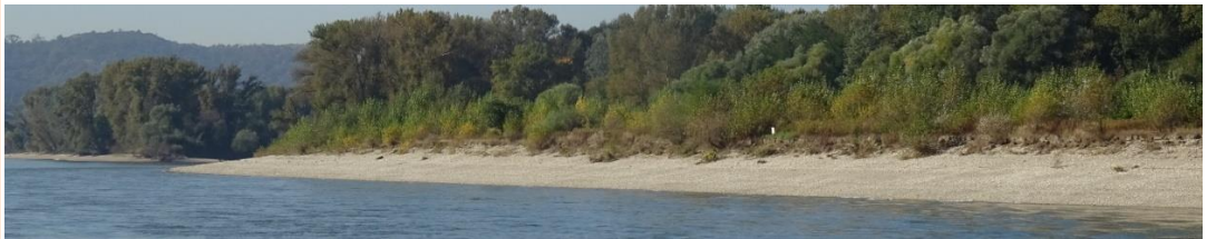
Abb. 7.1-1: Abgeflachtes Ufer mit typischer Vegetationszonierung nach Rückbau der Ufersicherung (Steinschüttung)
