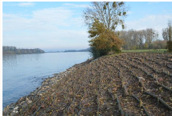
Abb. 7.3-1: Einbau von Weidenspreitlagen als Ufersicherung
