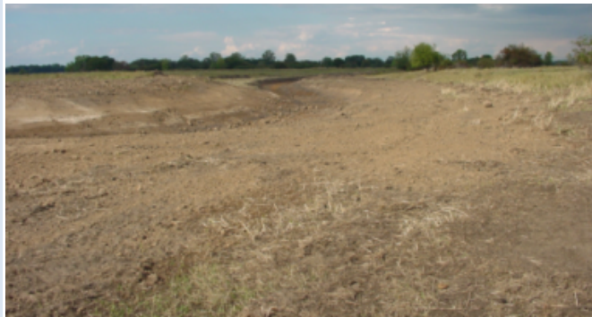
Abb. 6.1-1: Bauliche Gestaltung eines naturnahen Gewässerlaufes
