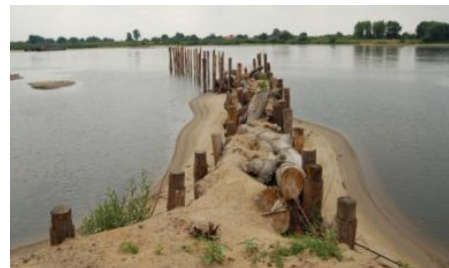
Abb. 2.2-2: Totholzbuhne als alternativ technisch-biologisches Regulierungsbauwerk
