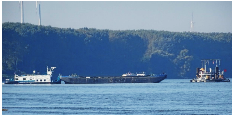
Abb. 1.3-1: Naturversuch zur Sohlsicherung durch Zugabe von grobem Geschiebe
