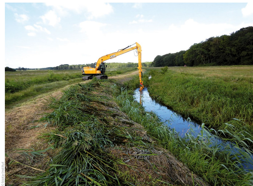
Bild 2: Krautung mit Langarmbagger und Mähkorb. Im Vordergrund sieht man das abgelegte Mähgut.
